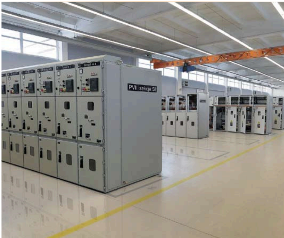
Hala produkcyjna firmy Elektromontaż Poznań SA
